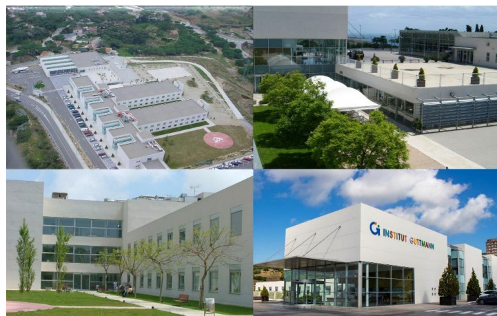
FIGURA 2: Instalaciones del Hospital de Neurorehabilitación Institut Guttmann (Badalona).
